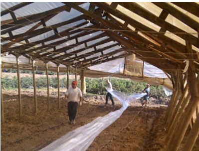
Imagen 49: Estiramiento del polietileno
