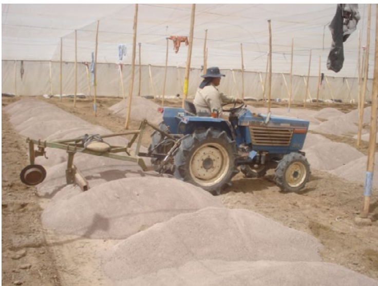
Imagen 36. Esparcimiento de áridos, macronivelación, Región de Arica y Parinacota.
