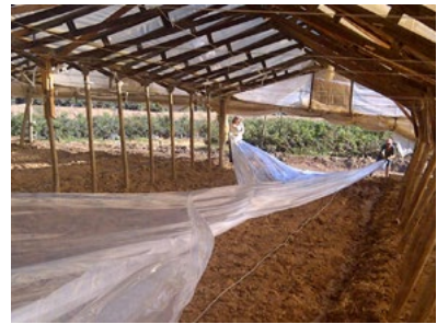
Imagen 50: Estiramiento del polietileno
