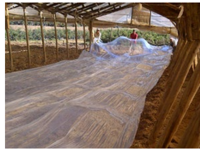
Imagen 52: Apertura del polietileno
